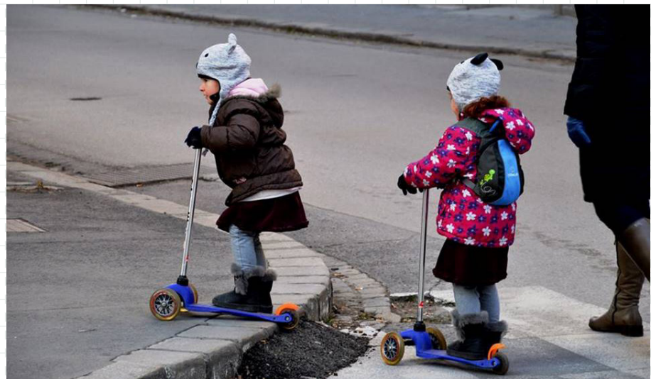
16 Bariérové priechody s nevhodnou výškou obrubníka, ktorá komplikuje prechádzanie cez priechod pre chodcov, sú neprípustné. Bratislava, Grösslingová ulica
